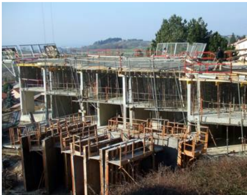
■ La réception du chantier est prévue en janvier 2014. Photo Michèle Dubuy
