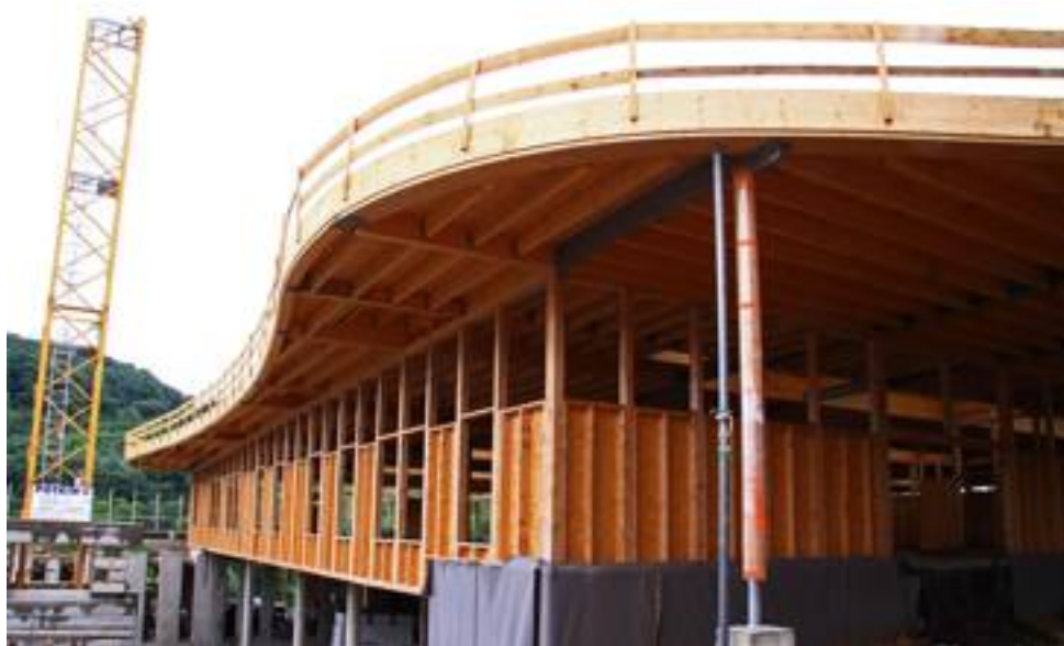
■ Sur la partie de gauche, l'espace réservée au périscolaire.
