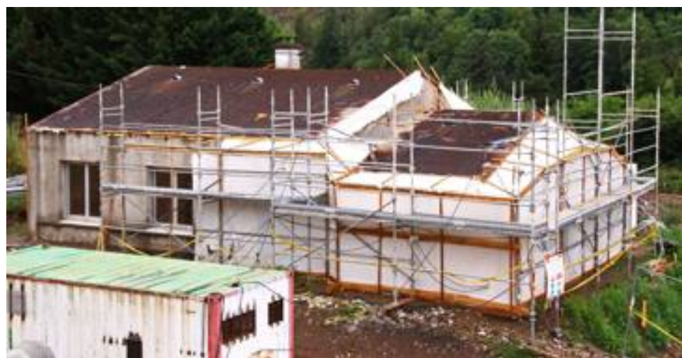
■ La petite maison des enseignants n'est plus qu'un souvenir : l'opération fastidieuse et coûteuse du désamiantage est terminée. Photos Georges Picq
