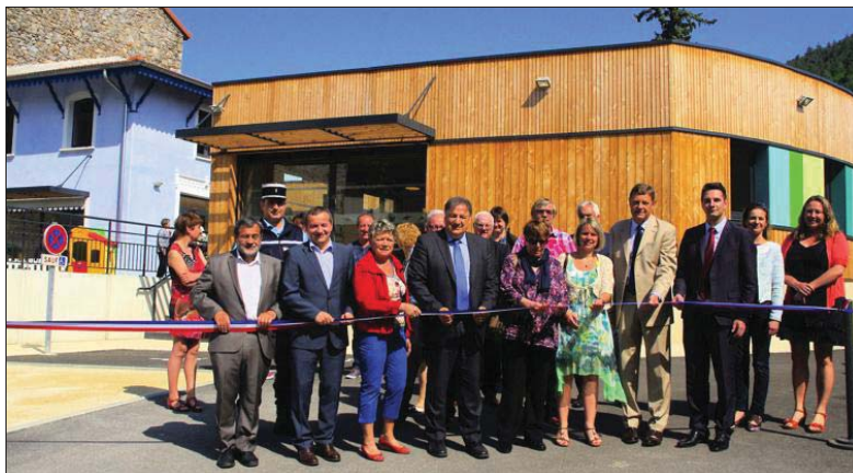
■ Au moment de couper le ruban, derrière les officiels le bâtiment neuf où le bois et l'isolation s'inscrivent bien dans une perspective de développement durable, et à gauche l'ancienne dépendance rénovée (en bleu). Photos Jean DESMARTIN
