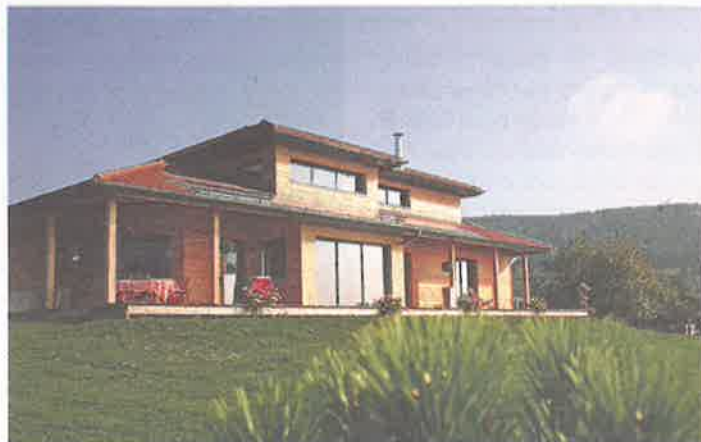
Une réalisation de la société Lignatech de Saint-Haon-le-Vieux
