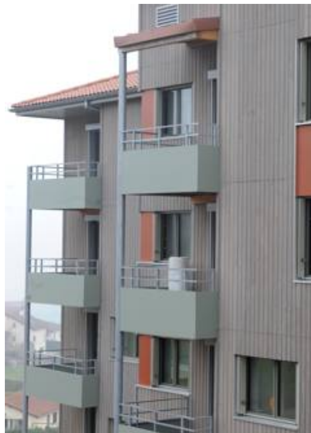
■ L'immeuble La Galachère est équipé d'une production d'eau chaude solaire ou encore de fenêtres triple vitrage. Photo Yves Flammin
