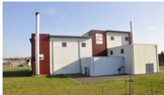
■ L'installation d'une deuxième chaudière bois au sein de la chaufferie pourrait être envisagée. Photo DR
