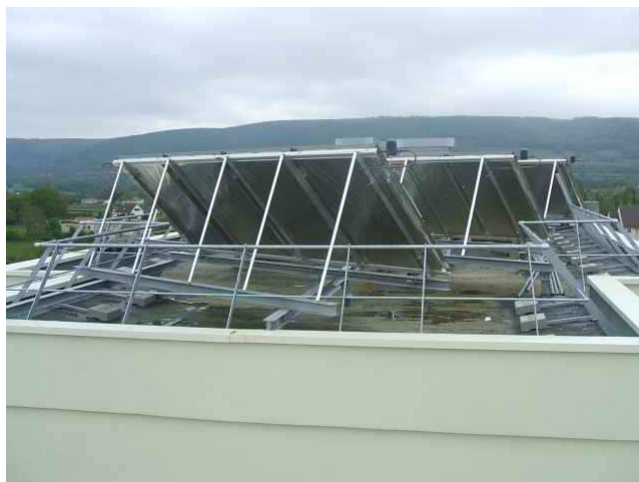
Pose de 101 m 2 de panneaux solaire sur ossature métallique.
