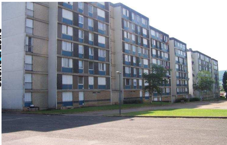
Avant travaux - Façade EST
