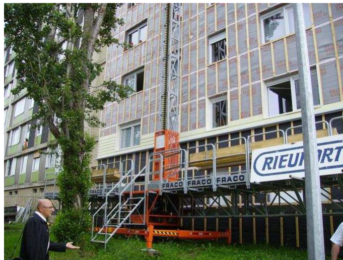
Pose des fenêtres, tasseaux de fixation en bois et du bardage en panneaux stratifiés.
