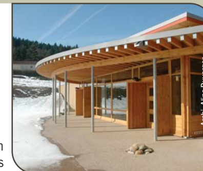
Baies vitrées au sud protégées par un large débord de toit
