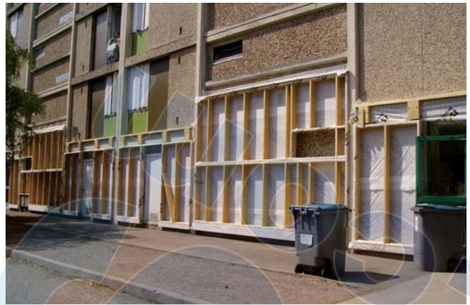
La mise en place des cadres en bois.
