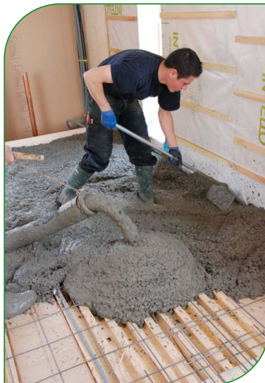
Mise en place d'un plancher Lignadal®, en bois et béton collaborant. L'intérêt est à la fois mécanique, acoustique et thermique (apport d'inertie).
