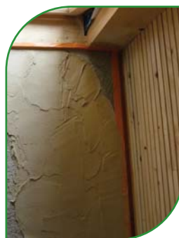
Ajout d'un enduit chaux-sable (5 cm) en doublage intérieur des murs ossature bois.
