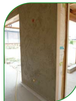
Ajout d'un enduit chaux-sable (5 cm) en doublage intérieur des murs ossature bois.
