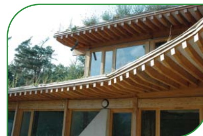
Baies vitrées au sud protégées par de larges débords de toits
