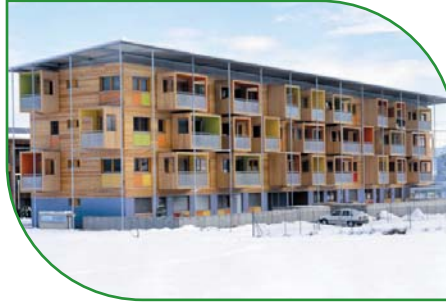
Immeuble R+3 en panneaux massifs
