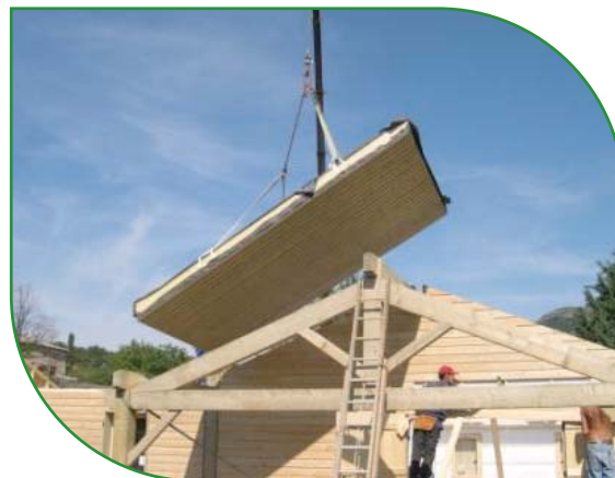
Pose de panneaux de toiture isolés
