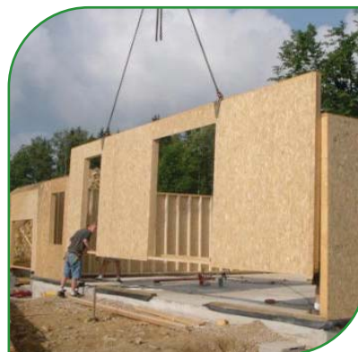
Pose sur chantier de panneaux préfabriqués, sans isolation ni bardage
