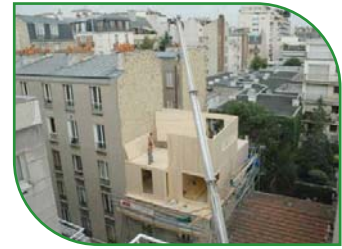
Exemple de chantier en panneaux massifs
