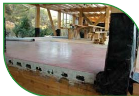
Renforcement de l'inertie thermique par des matériaux lourds dans les dalles, les cloisons et les murs de refends
