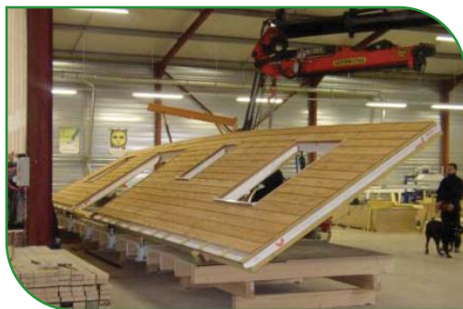
Préfabrication de panneaux avec pose du bardage en atelier
