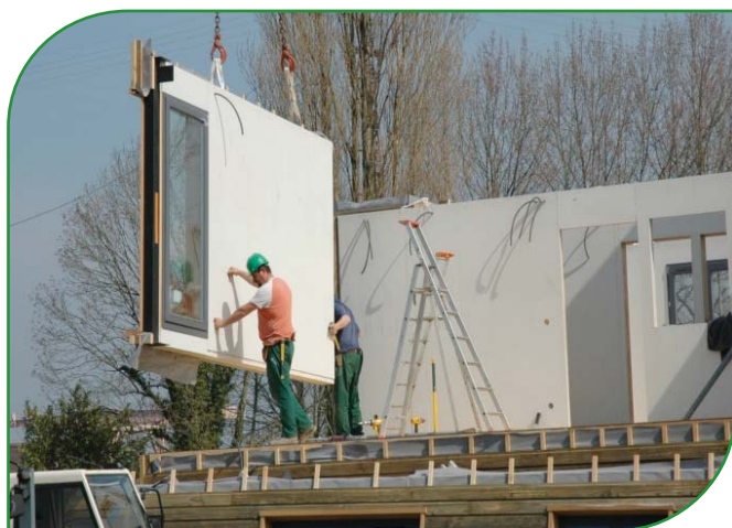
Pose de panneaux préfabriqués avec isolation, menuiseries extérieures, et parement intérieur
