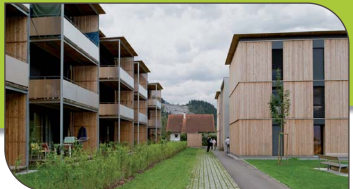
Les balcons autoporteurs, désolidarisés de la structure, suppriment un pont thermique
